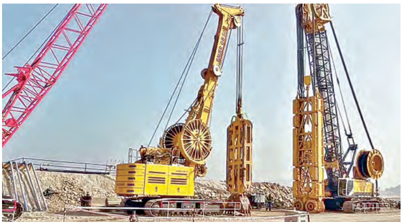
శనివారం పోలవరం డయాప్టం వాల్ నిర్మాణ పనులు ప్రారంభించిన దృశ్యం
